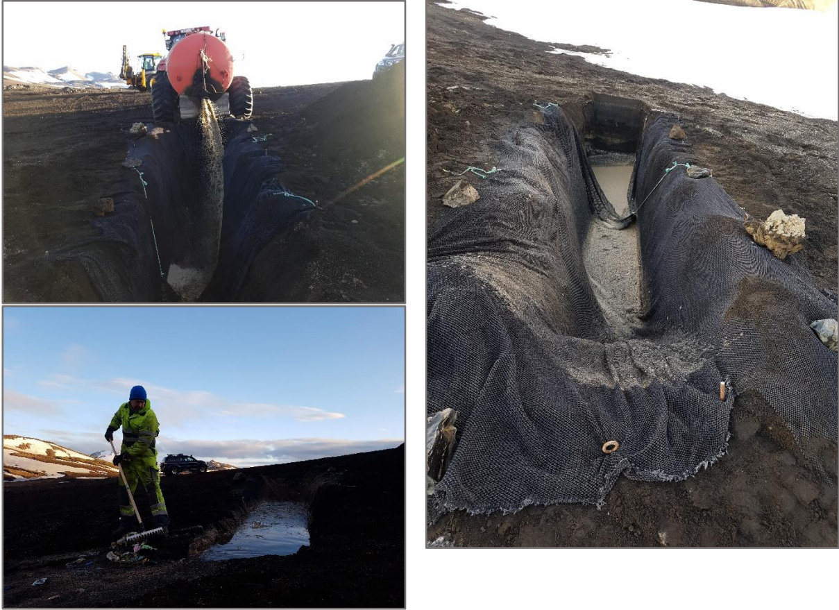
MYND 6 Tilraun Ferðafélags Íslands til að grófhreinsa sorp úr salernisúrgangi frá Höskuldsskála 14. september 2018. Fyrsta mynd sýnir haugsugu sem tæmdi safntanka við skálann og næstu tvær myndir sýna rækjunetið sem strengt var yfir botn og hliðar gryfju sem grafinn var til förgunar salernisúrgangsins. Síðustu þrjár myndirnar sýna salernisúrganginn í gryfjunni og skálavörð Höskuldsskála er hann rakar úrgangi úr netinu (ljósmyndir frá Ferðafélagi Íslands, 2019).
