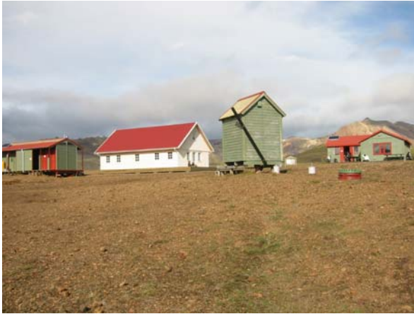
Mynd 5.1 – Útikamar og rotþró sunnan við skála
